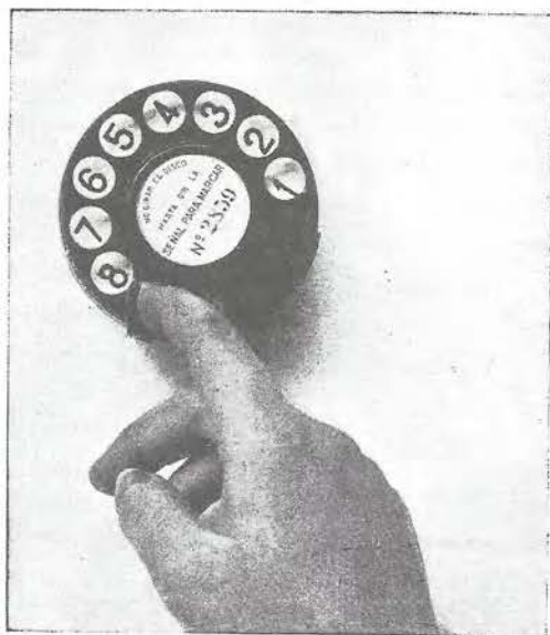
11. el disco como es sabido, hasta tropezar con el tope de parada. El dedo se suelta finalmente.
