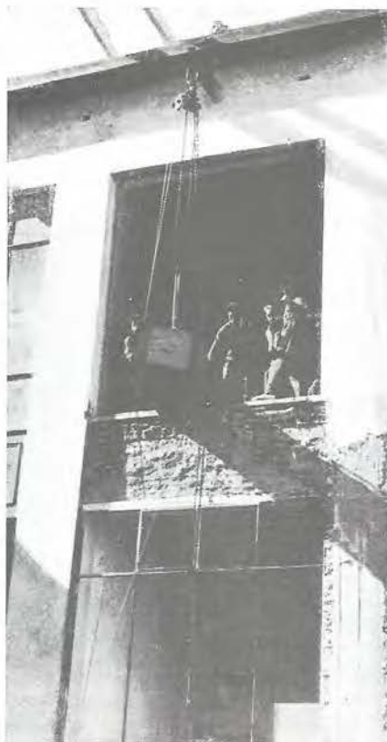
Llegada de una caja con equipo automático.
