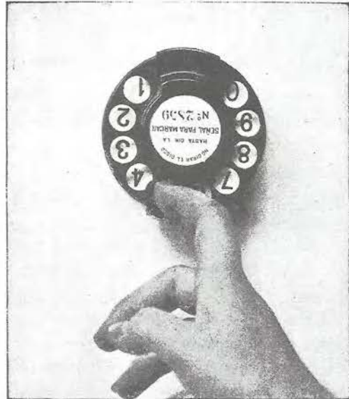
9. dando vuelta al disco hasta que lo impida el tope, y soltando después.
