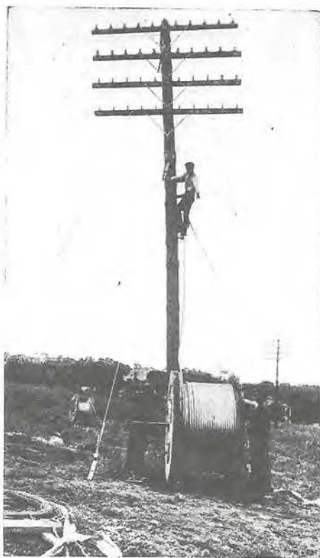
Suministro de cable bajo plomo mientras se tiende el cable soporte de acero.
